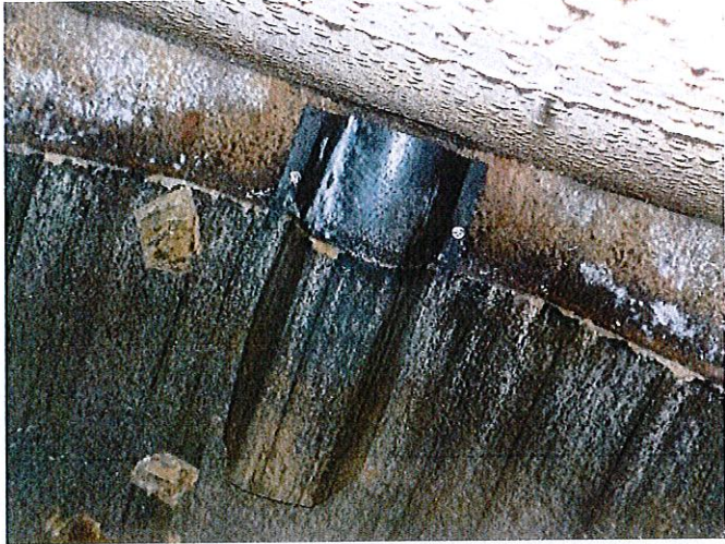
Outlet baffle
