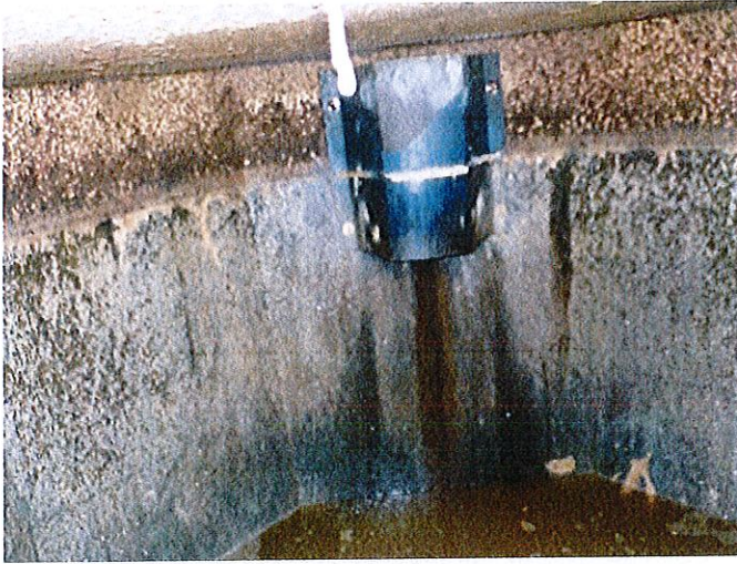
Inlet baffle
